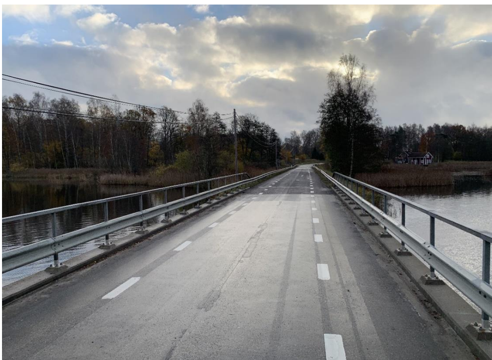
Figur 6. Bygdevägen går över Idekullabron som till största del är en bro på en vägbank. Foto: Tingsryds kommun.
