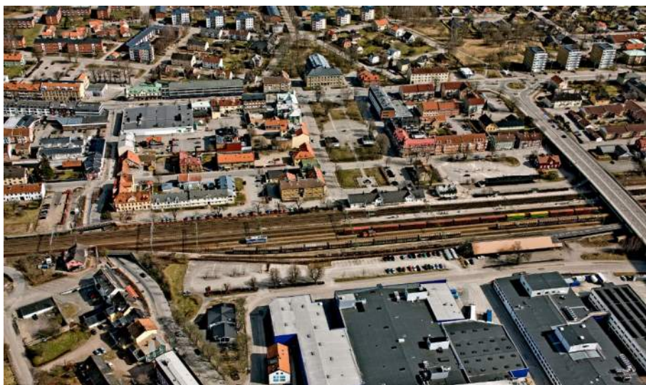
Figur 75 Älmhults stationssamhälle, Ikea i Älmhult bredvid södra stambanan i det flacka mosaiklandskapet. Fotograf Bergslagsbild AB. (Flygfotografering genomförd den 10 april 2011)
