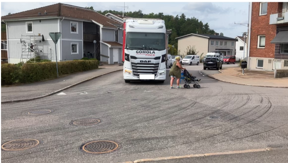
Övergångsställen saknas och linjemålningen är bristfällig. Däckspåren i asfalten vittnar om kraftigt gummislitage vid den för tvära svängen.
