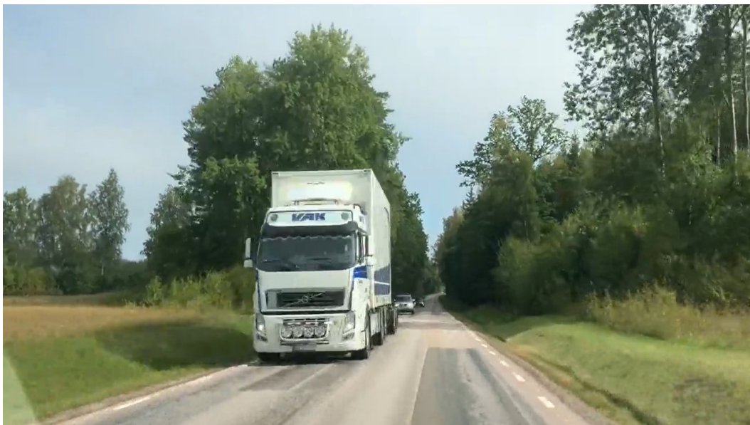
Bild från Alandsköp mellan Strömsnäsbruk och Axhult. Sträckan trafikeras av Länstrafikens bussar (linje 150) med hållplatser där resenärerna, till följd av de minimala vägrenarna, får gå av och på eller vänta på vägbanan eller i dikesrenen.
