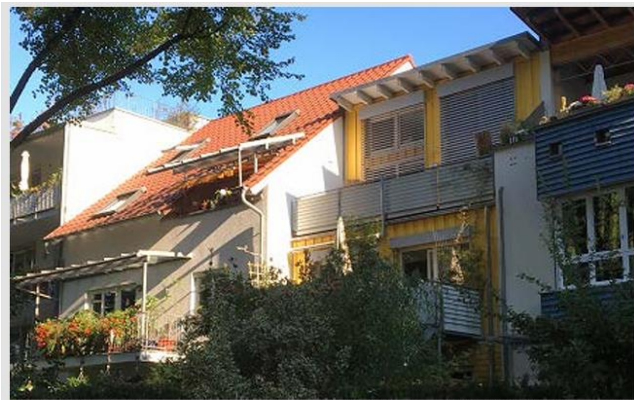
Stadsdelen Vauban omfattar ett 40 hektar stort f.d. kasernområde i Freiburg. Ca 60 byggemenskaper har här skapat sina egna, vanligen småskaliga fastigheter med sammanlagt 2 000 lägenheter. Stadsdelen har idag ca 5 500 invånare.
